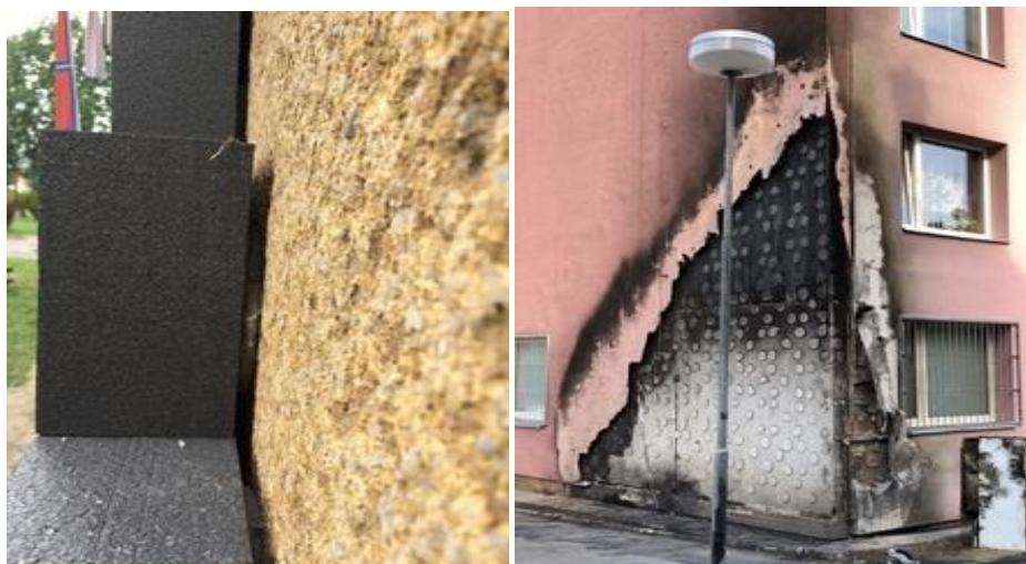
Chybné lepení ETICS tzv. na buchty, vpravo ETICS lepený na buchty po požáru, foto: TZB-info
