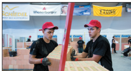
Disciplína ve vyzdění rohové obvodové stěny s překladem z broušených ohebel Porotherm
