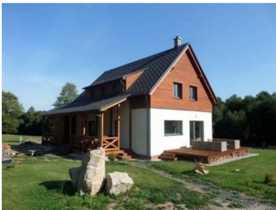
Rodinný dům Pod Ořešníkem, novostavba, dřevostavba, autor: LIDOVÉ BYDLENÍ s.r.o.
