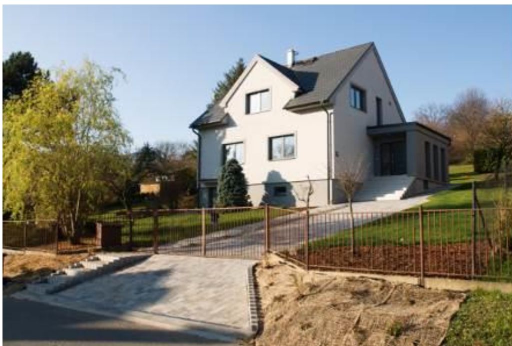
Kompletní rekonstrukce domku z 50. let, zděná/monolitická, autor: Tamara Staňková
