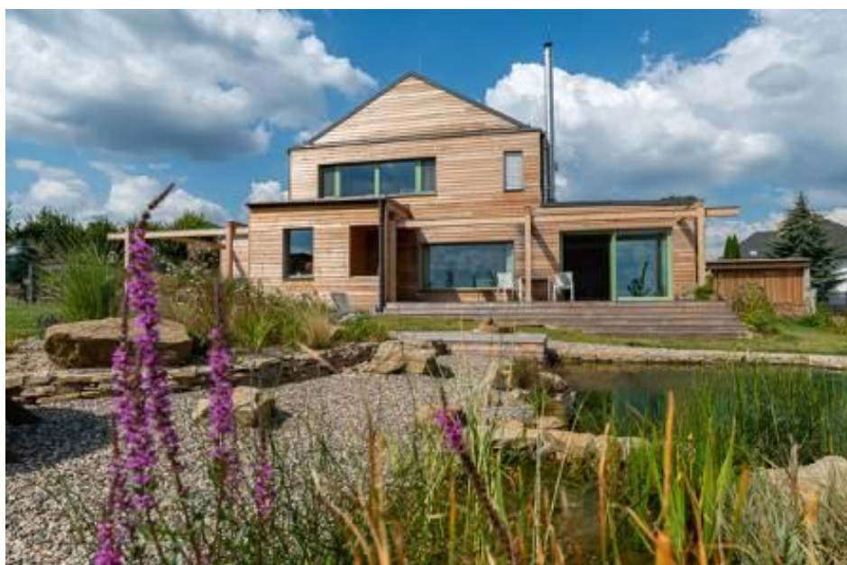
Rodinný dům v Dobříši, novostavba, dřevostavba, autor: Novahome s.r.o.
