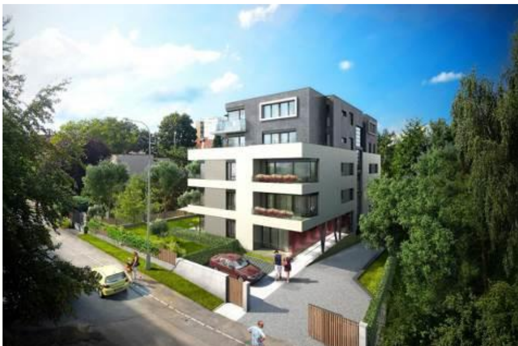
Vila Na Výsluní, novostavba bytového domu, zděná/monolitická, autor: Podlipný Sladký architekti s.r.o.
