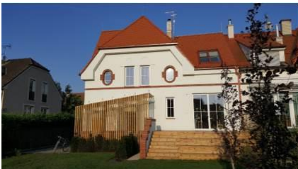
Rekonstrukce poloviny dvojdomu z r. 1930, Poděbrady, zděná/monolitická, autor: Ondřej Kamenický
