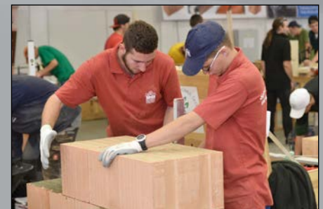
Disciplina ve vyzdění rohové obvodové stěny z broušených cihel Porotherm - Wienerberger cihlářský průmysl
